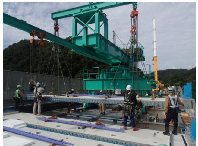
(江の川第三橋他1橋床版取替工事)
