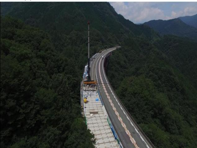
(容谷橋床版取替)
