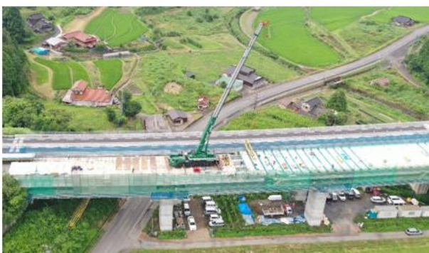
高速道路床版取替工事例：赤山橋 (山口県)
