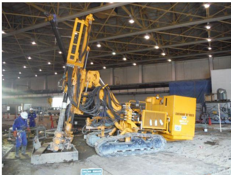
図表2-(1)-6. マイクロパイル工法の工事例
