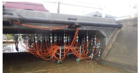
交通規制を伴わないK-LIP工法による床版補修への対応事例
