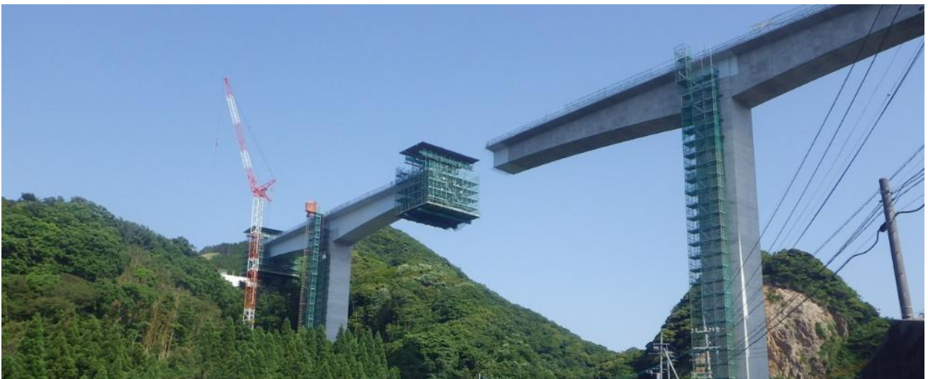
図表1-(1)-1. 建設中のPC橋
