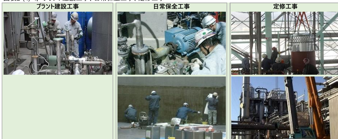
図表2-(4)-4. プラント建設工事、日常保全工事、定修工事
